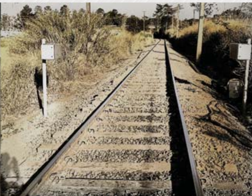
Antenas para leitura dos tags, posicionadas ao lado dos trilhos.
