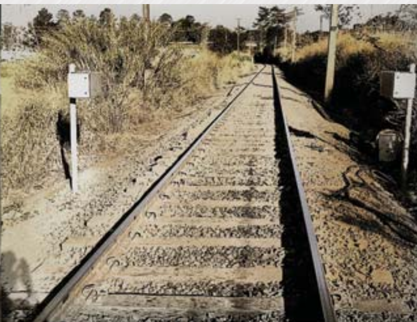
Antenas para Lectura de los Tags, ubicadas al lado de los rieles.
